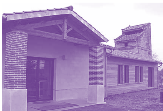
Façade restaurant et salles de formation
